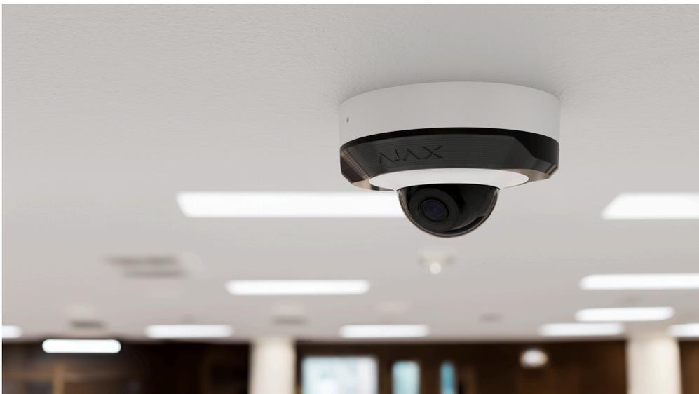
Bei der Wahl des optimalen Standortes zur Installation von DomeCam Mini sind der Blickwinkel der Kamera sowie mögliche Hindernisse, die die Sicht der Kamera beeinträchtigen können, zu berücksichtigen.
